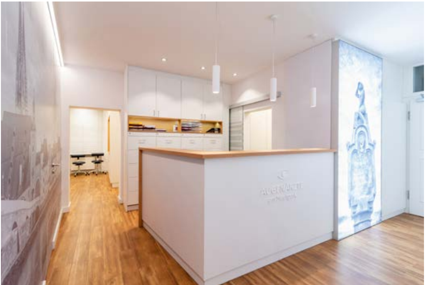
Abb.: Über dem Empfangstresen kommen weiße, optisch zurückhaltende Pendelleuchten zum Einsatz, die durch drei schwenkbare Downlights für die Möbelwand hinter der Theke ergänzt werden. Neben der Eingangstür zeigt das vollflächig hinterleuchtete Spanndia eines der Wahrzeichen von Regensburg. Die LEDs in Tageslichtfarbe (6000 K) wurden auf einem weißen Aluminiumblech aufgebracht und mit einem bedruckten Stoffgewebe überspannt.
